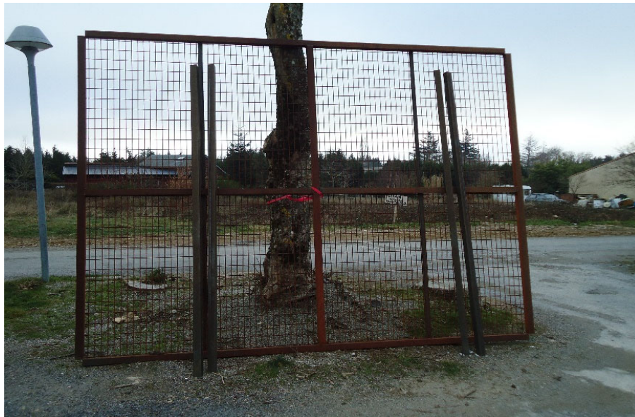
Confection d'une pergola pour l'aire de pique-nique dans le but de faire grimper une plante grimpante qui à terme fournira de l'ombre.
