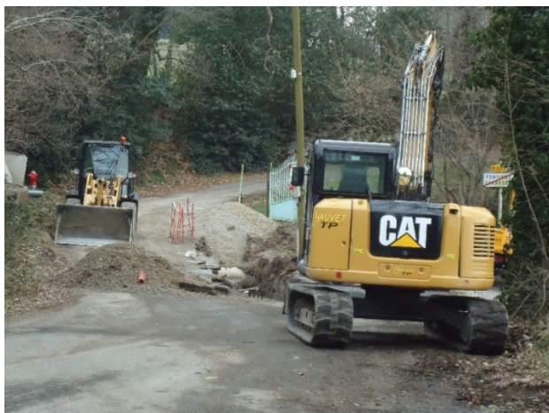
Travaux réseaux Eaux Usées route de Carcassonne
