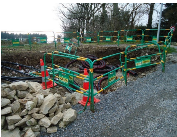
Emplacement du futur transformateur rue de la Carrierrasse
